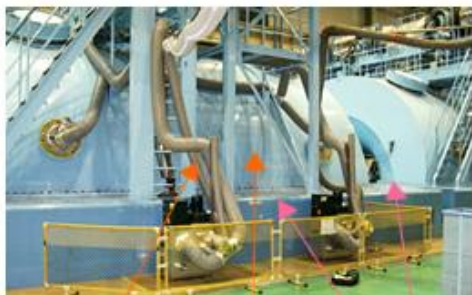
タービンへ除湿乾燥 空気を送風 タービン R-060BR型×2台
